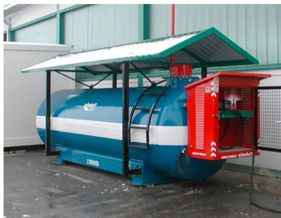
*Рис. 1. Мобильная АЗС закрытого типа*
