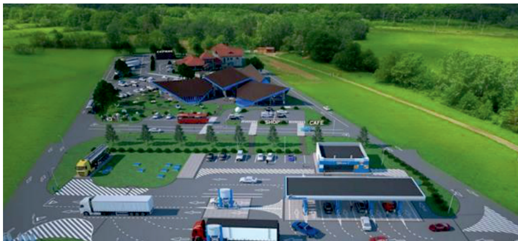
Комплекс зданий многофункциональной зоны придорожного сервиса [6]
