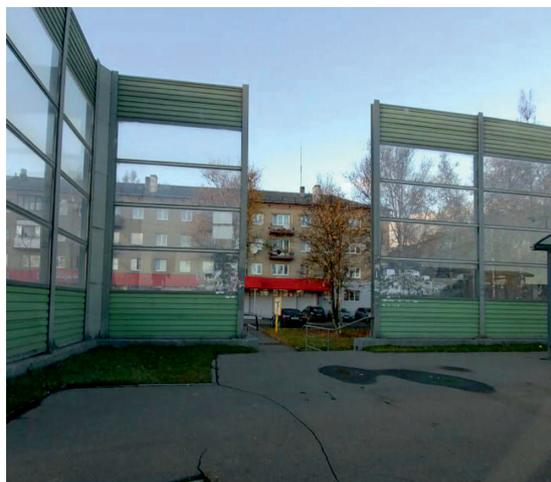
Рис. 3. Разрыв в конструкции АЭ на участке ФАД М-3, 47 км
