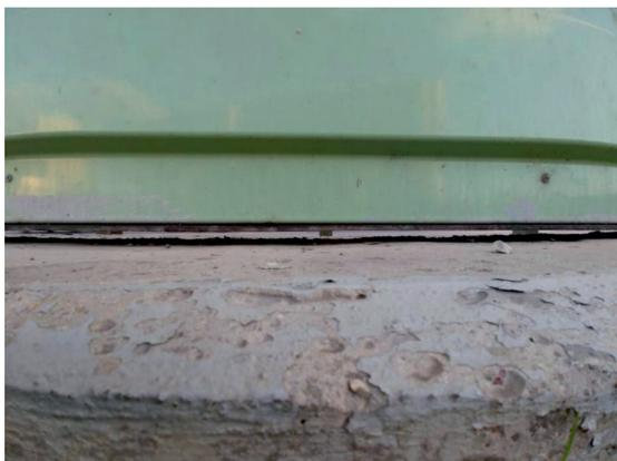
Рис. 1. Щель между ленточным фундаментом и нижней панелью АЭ, 46 км
