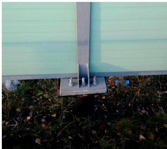
Рис. 2. Зазор 0,8 м между нижней панелью АЭ и грунтом на откосе, 48 км
